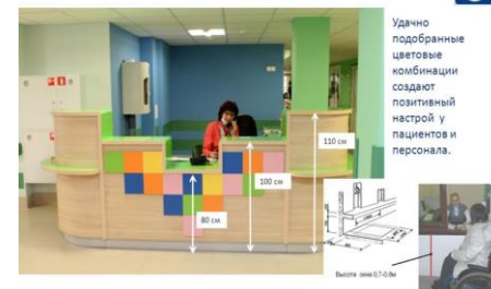
Административная стойка с разной высотой столешниц позволяет удобно обслужить пациентов с двигательными ограничениями.
